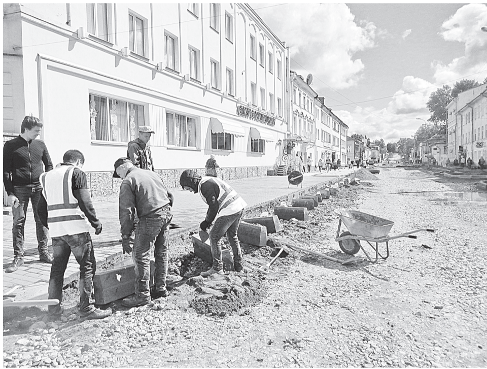
Установка бордюрного камня у магазина «Екатерининский»
